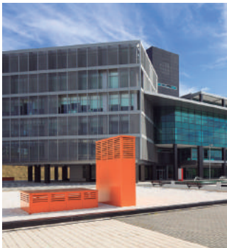
Parque Tecnológico de Andalucía Bureaux à haute efficacité énergétique, Espagne. ECOi
